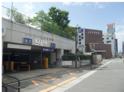
香澄駐車場 出入口
